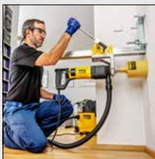
**REMS Picus DP – carotaggio senz'acqua con tecnologia a micro-impulsi. Lavoro pulito, facile e veloce, ad esempio 200 mm in cemento armato Ø 62 mm in soli 5 minuti.**
